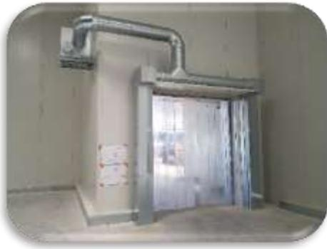
Standardmäßig wird dieses Basissystem auf der Gefrierseite installiert. Im Gegensatz zum typischen Masterveil-Ansatz wird die maßgeschneiderte Länge durch die Kombination von Standardmodulen erreicht.
