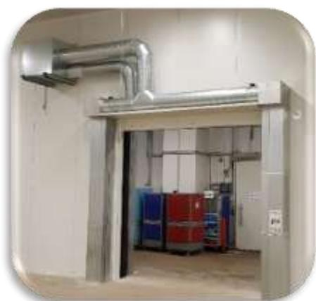
Ce système unique de rideau d'air haute pression a été spécialement développé pour être utilisé pour les portes entre les grands congélateurs en combinaison avec les grandes pièces climatisées. Ici, la fonction de séparation de la température et de l'humidité est divisée en deux fonctions individuelles.
