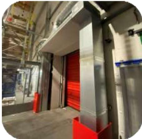
Standardmäßig wird dieses Basissystem auf der Gefrierseite installiert. Im Gegensatz zum typischen Masterveil-Ansatz wird die maßgeschneiderte Länge durch die Kombination von Standardmodulen erreicht.
